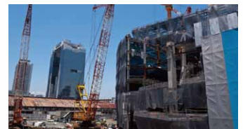
建設現場の作業連絡
